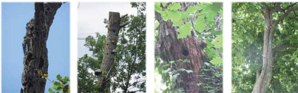
Exemples d'arbres présentant des loges de pic, des décrochements d'écorce ou des fissures favorables aux chiroptères arboricoles
